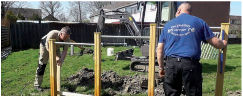
Vorige week is het speelplekje bij de Kustweg en Kattegat aangelegd.
